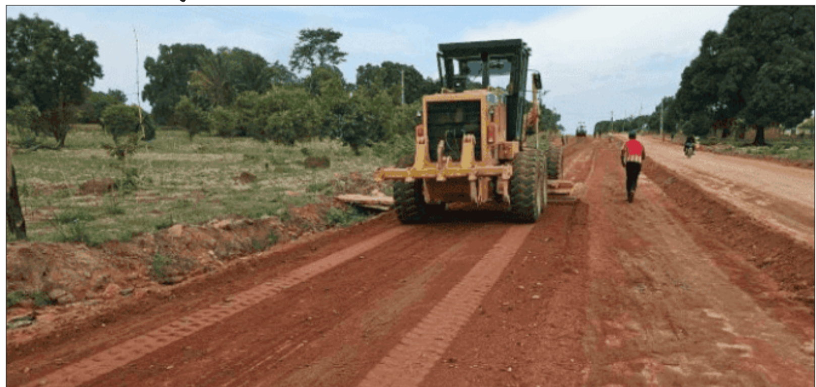
Katsina-Ala-Takum road project
